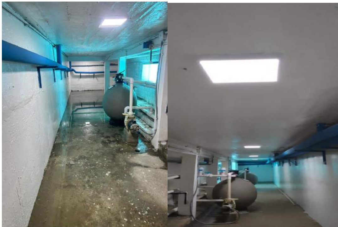
FIGURA 7. Adecantamiento de tuneles y cuarto de sistema hidroneumático de las piscinas del complejo acuático Garay - Vallarino
