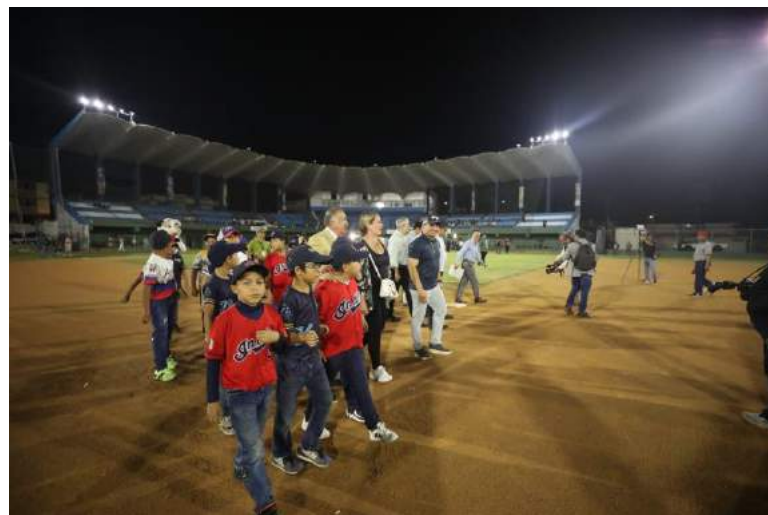
FIGURA 3. Rehabilitación y repotenciación del sistema de iluminación en el estadio de béisbol "Yeyo Úraga"
